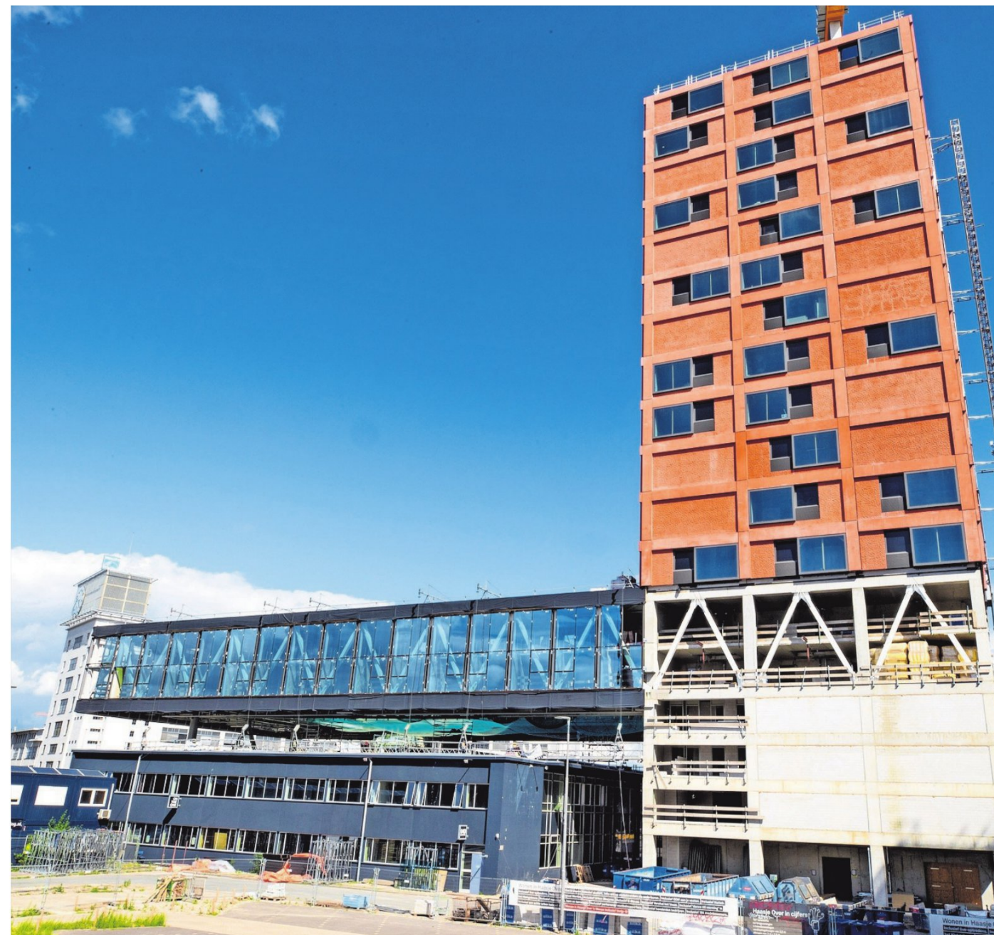
▲ De bouw van Haasje Over op Strijp-S vordert gestaag. Begin volgend jaar moet de bouw gereed zijn en kunnen de bewoners er in. FOTO DCI/MEDIA
