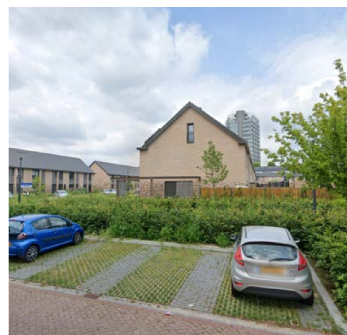
Parkeren op grasbetonstenen
